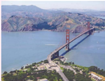
Рис. 149. Мост через пролив Золотые Ворота
