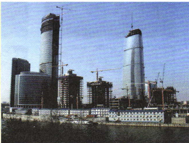
Рис. 47. Строительство делового центра — Сити — в Москве (Россия)
