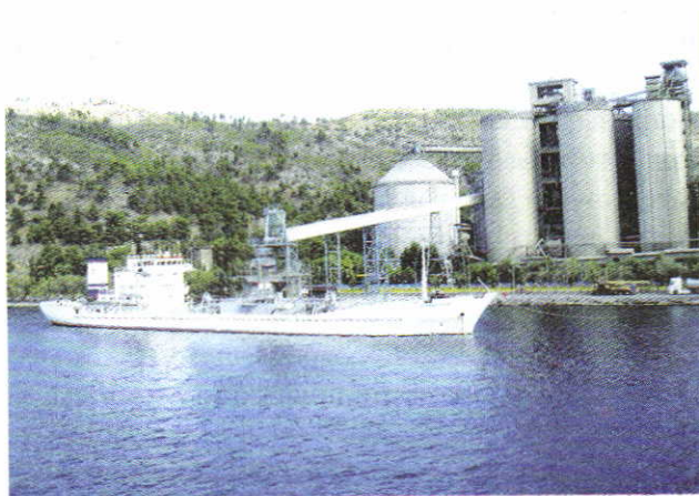
Рис. 158. Цементный завод (Греция). Географическое положение предприятия — на берегу моря — обеспечивает удобную и дешёвую транспортировку готовой продукции
